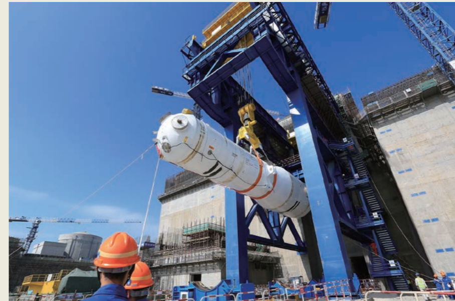
吊装蒸汽发生器
