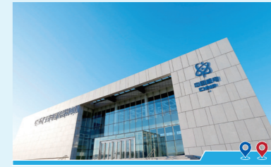
辽宁省兴城市 中核辽宁核电有限公司宣传展览中心
